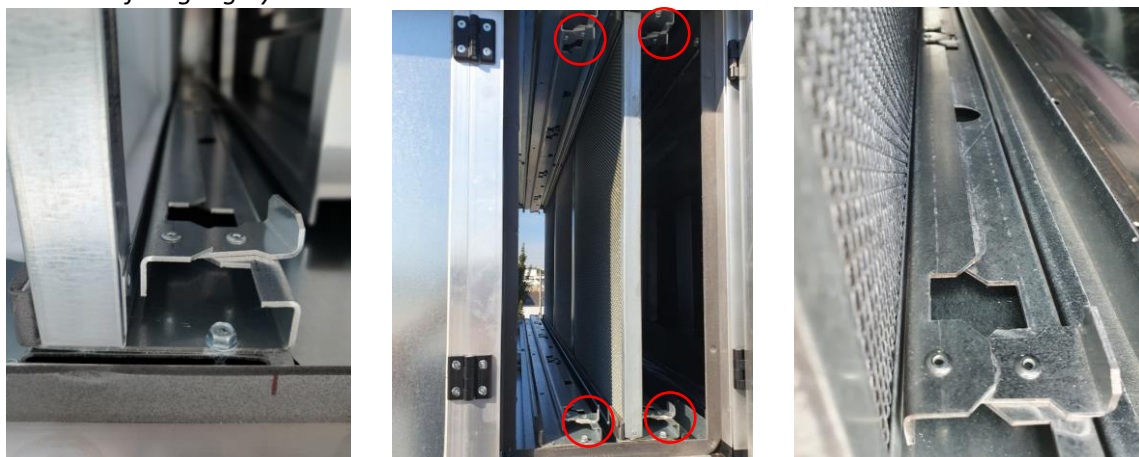
Abb. 1: Befestigungssystem der Filter in der Filterkammer
